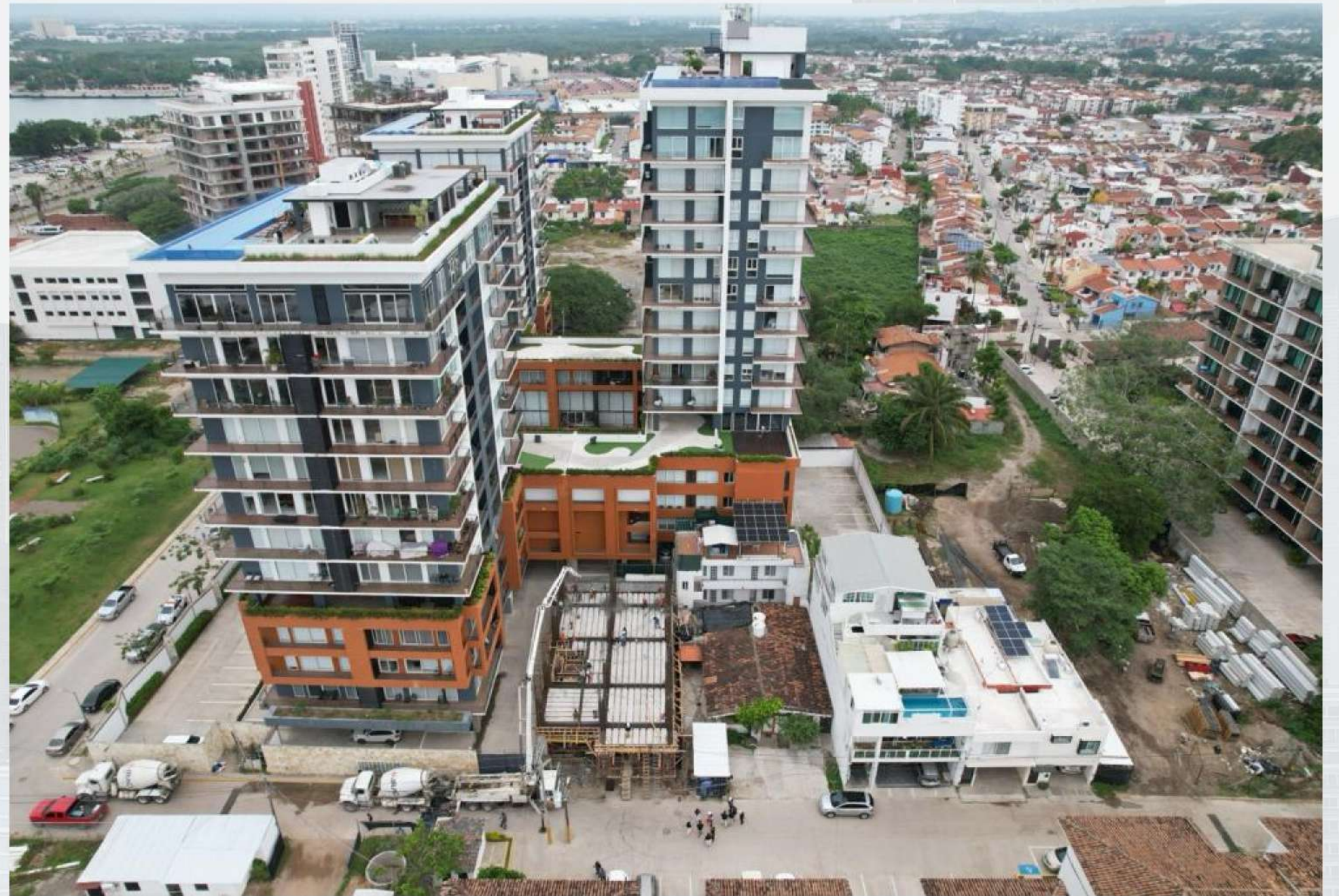
TRABAJOS PARA COLADO DE PRIMER LOSA
