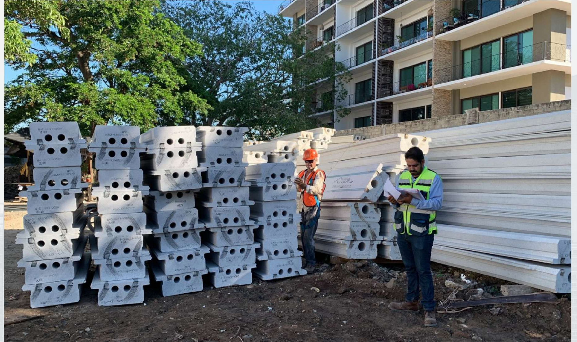
ARRIBO DE MATERIALES DE LOSAS NIVEL 3, 4 Y 5
